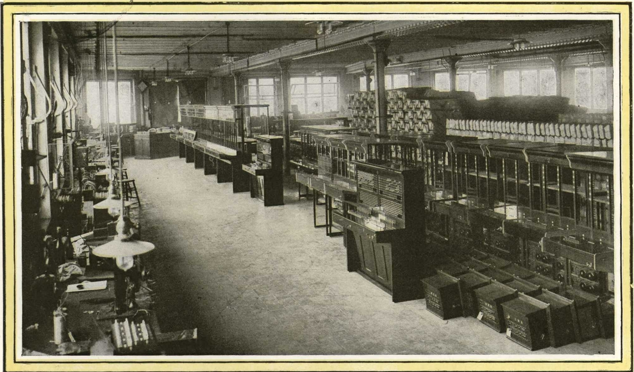
Salle de montage des grands commutateurs.
