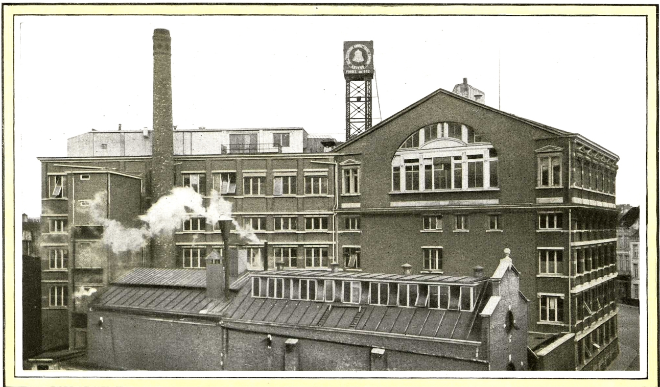
Vue d'arrière du bâtiment principal et de la salle des machines.
