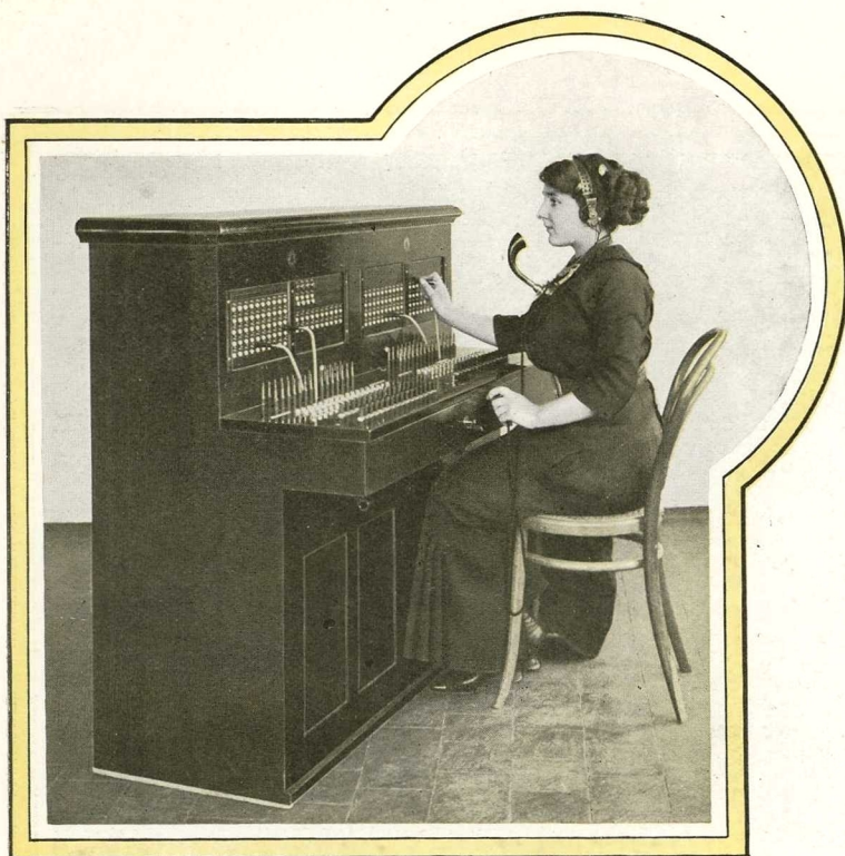
Installation privée de l'établissement.
