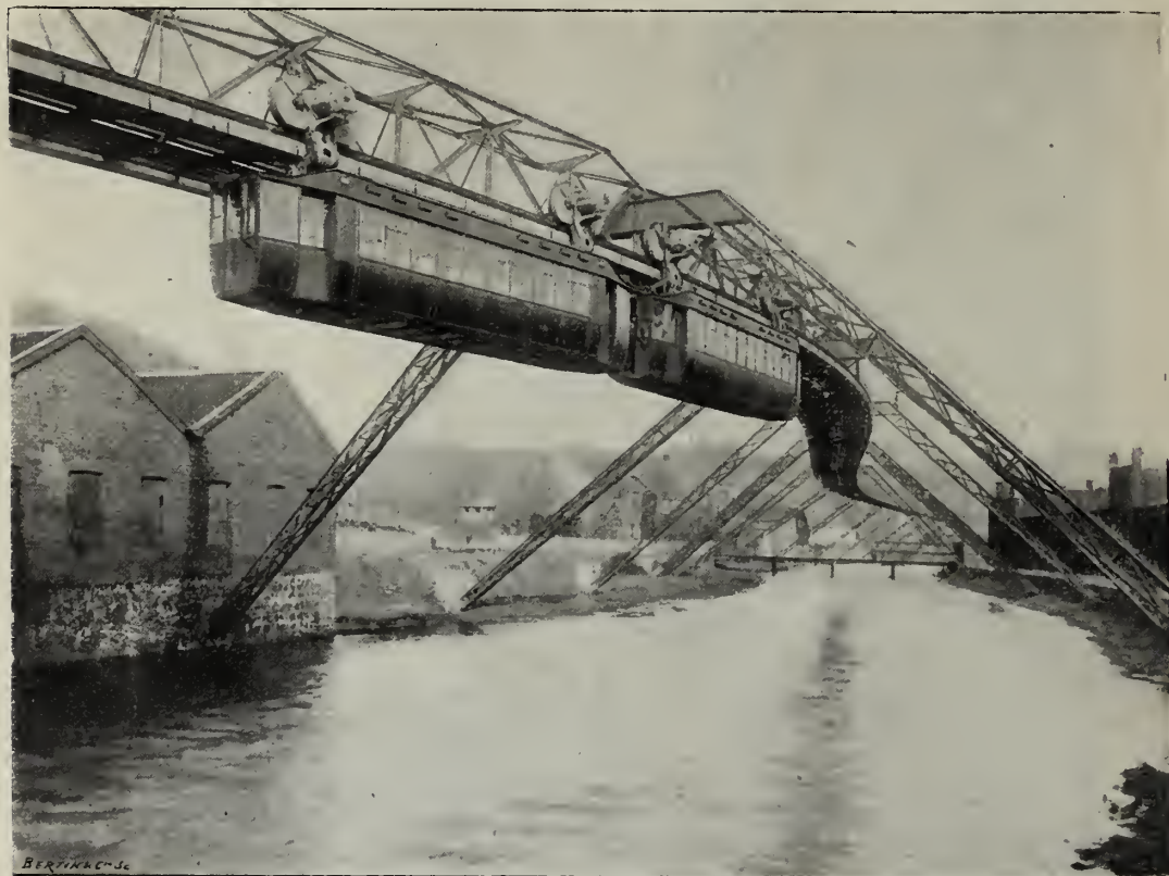
FIG. 19. — Monorail Langen. Ligne de Barmen à Elberfeld.
