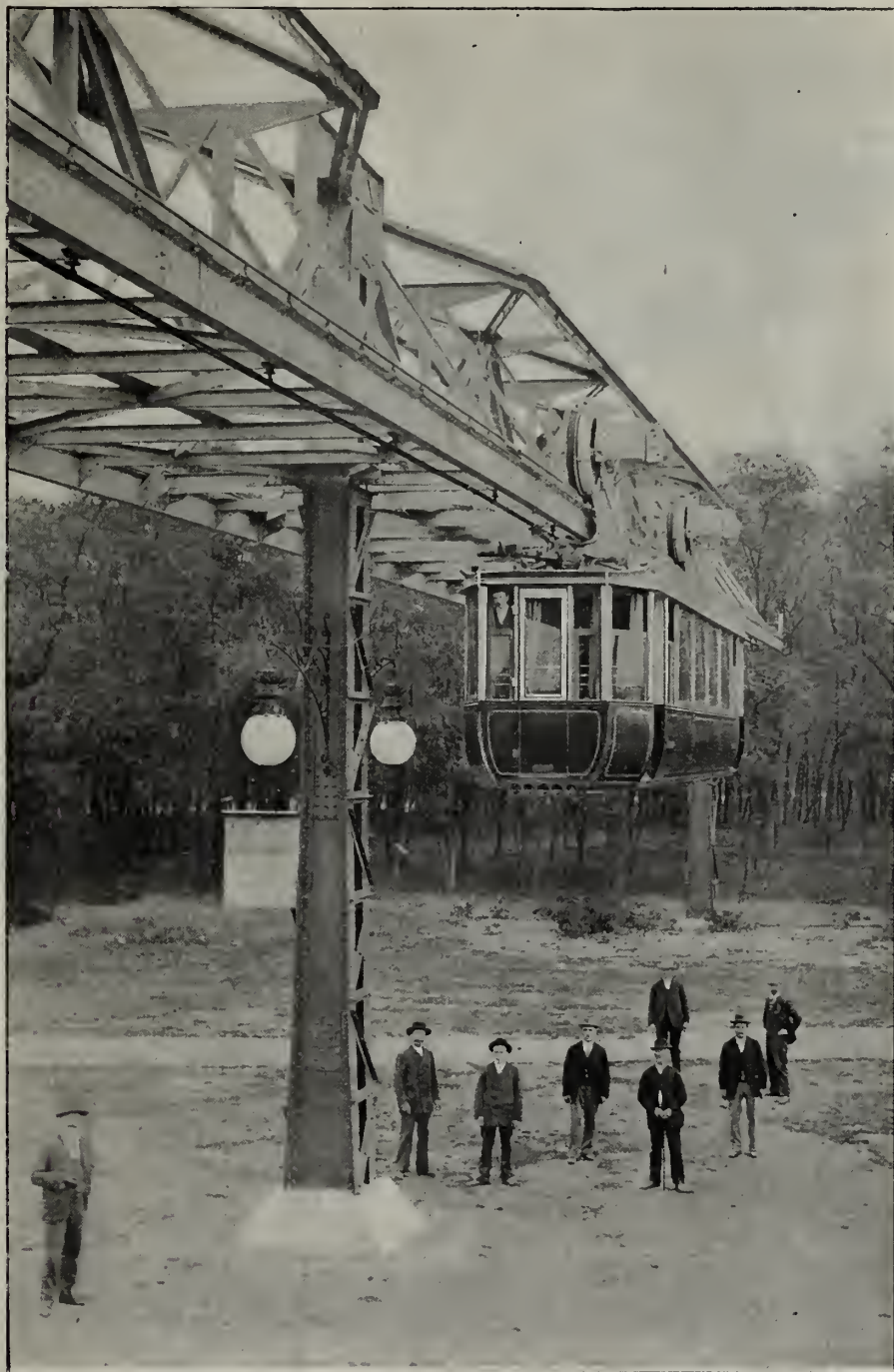
FIG. 18. — Chemin de fer monorail, système Langen. — Tronçon de ligne exposé à Vincennes.
