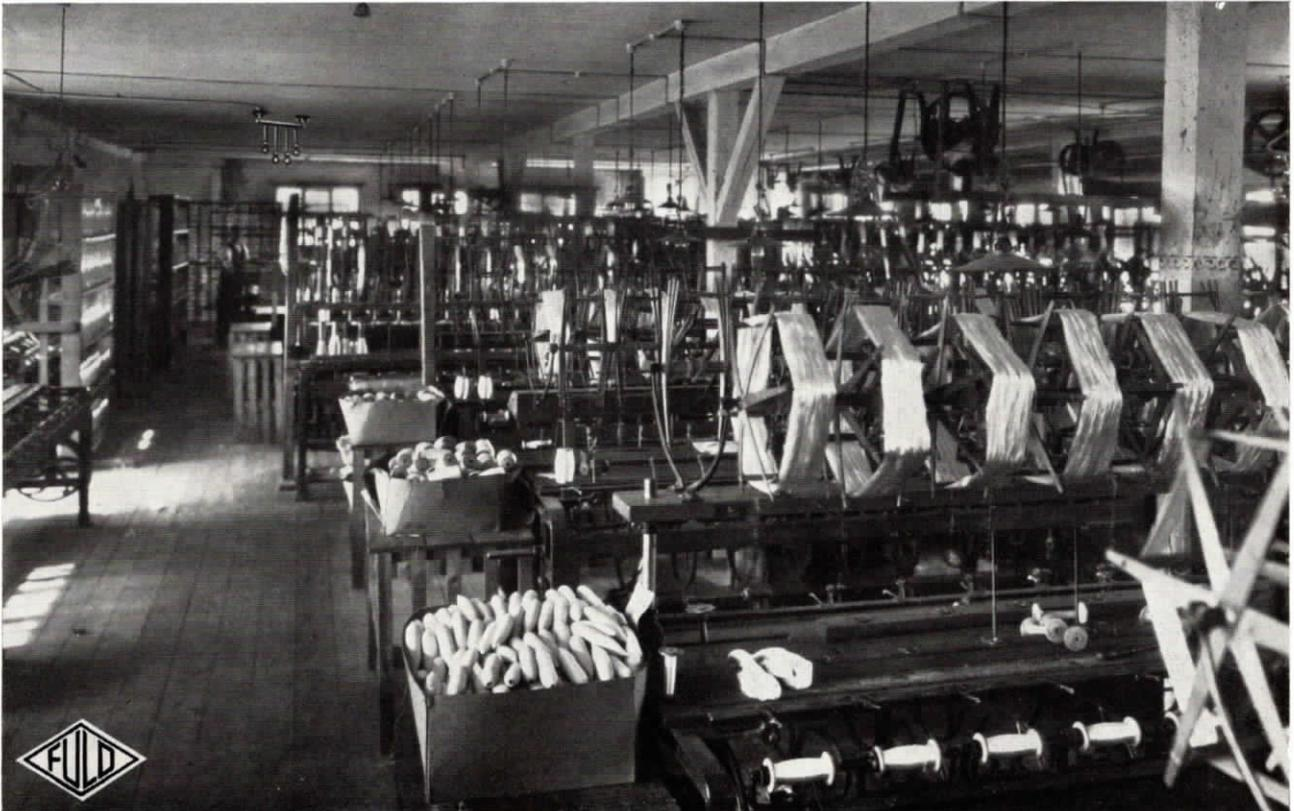
Abb. 32. Spulerei und Schererei mit Fuld-Lichttrufleinrichtung in der C. Hugo Eidner & Co. A.G. Handschuh-, Strumpf- und Wirkwarenfabriken in Göppersdorf bei Burgstädt i. Sa.
