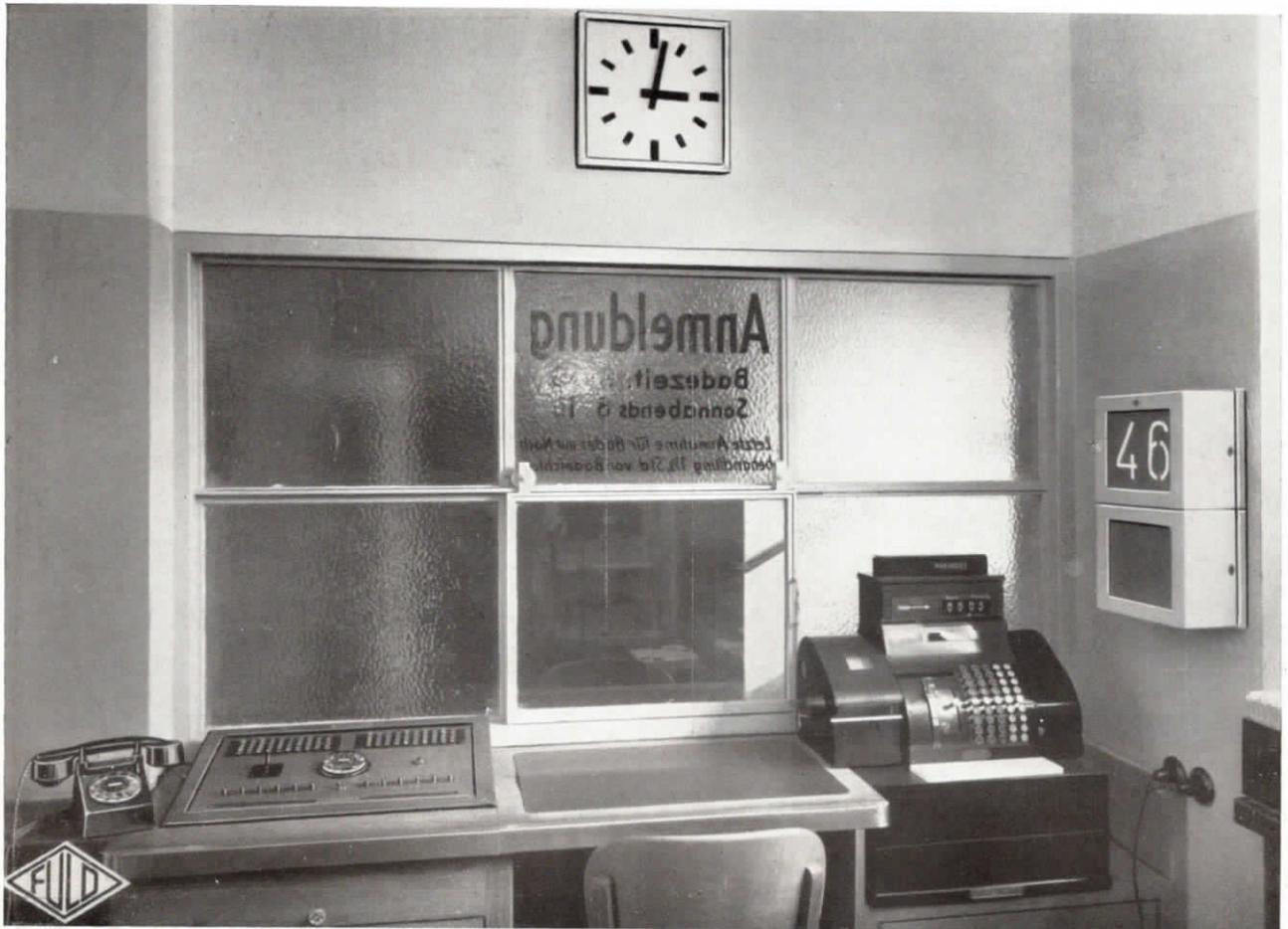
Abb. 17. Kasse der Badeanstalt in der Allg. Ortskrankenkasse Chemnitz mit Kabinen-Besetzmeldetablo für 50 Kabinen, mit automatischer, optischer Zahlenabrufanlage, unterteilt in zwei Gruppen für die Männer- und für die Frauenabteilung, ferner Fuld-Fernsprecher und Normalzeit-Nebenuhr
