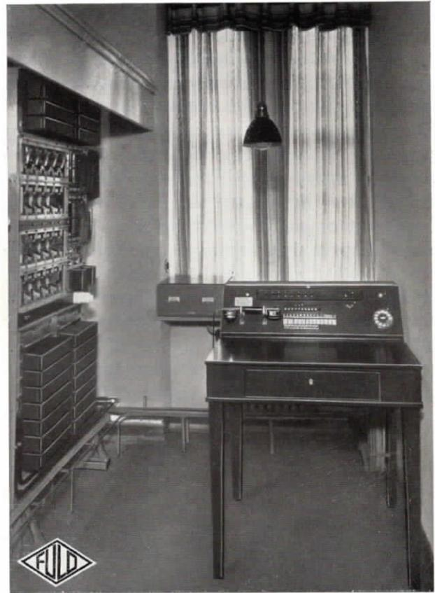
Abb. 34. Fernsprech-Zentralenraum der Aku-Verkaufskontor Glanzstoff Enka, in Chemnitz. Die Firma besitzt eine Fuld-Fernsprechanlage, bestehend aus einer halbautomatischen Nebenstellenzentrale in Pultform und einer vollautomatischen Hauszentrale für 30 Teilnehmeranschlüsse
