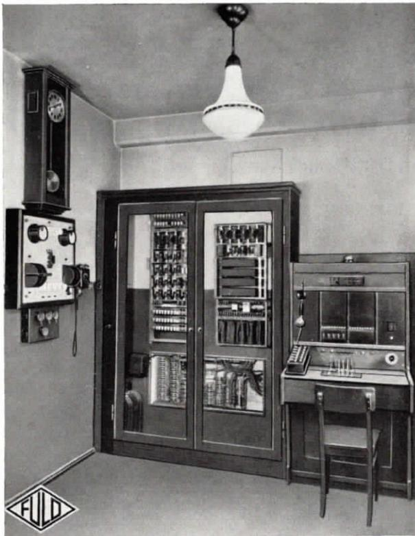
Abb. 5. Fernsprech-Zentralenraum in der Girozentrale Sachsen in Plauen mit halbautomatischer Fuld-Nebenstellen-Zentrale für 4 Amtsleitungen, 16 Nebenstellen und 9 Hausstellen, vollautomatischer Fuld-Hauszentrale für 25 Teilnehmeranschlüsse, Einschaltetastatur für die Lichtrufanlage, Ladeschalttafel und Normalzeit-Hauptuhr
