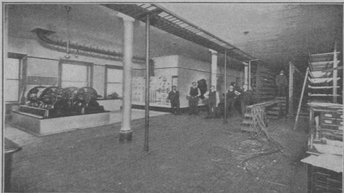
Fig. 199. — Vue générale de la salle des bâtis et des machines du bureau central de Los Angeles.
