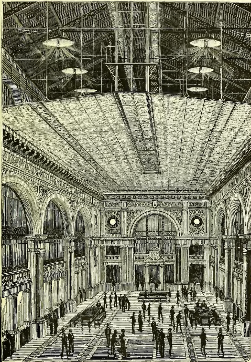
FIG. 62. — LA GRANDE SALLE DU COMPTOIR D'ESCOMPTE DE PARIS ÉCLAIRÉE PAR L'ARC VOLTAÏQUE ET LA PILE A CHROMATE DE POTASSE.
