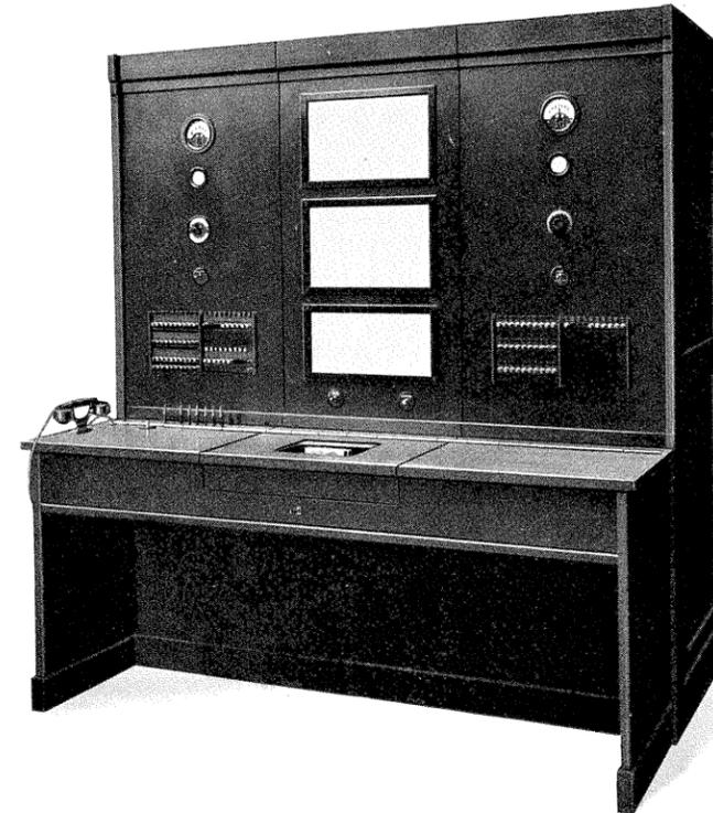
Abb. 30. Feuermeldezentrale der Stadt Brüssel (Strahlensystem).
