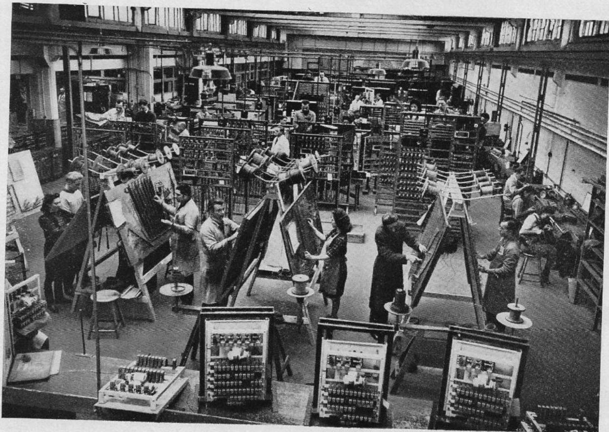
Zentralen-Montage (Werk Urberach)
