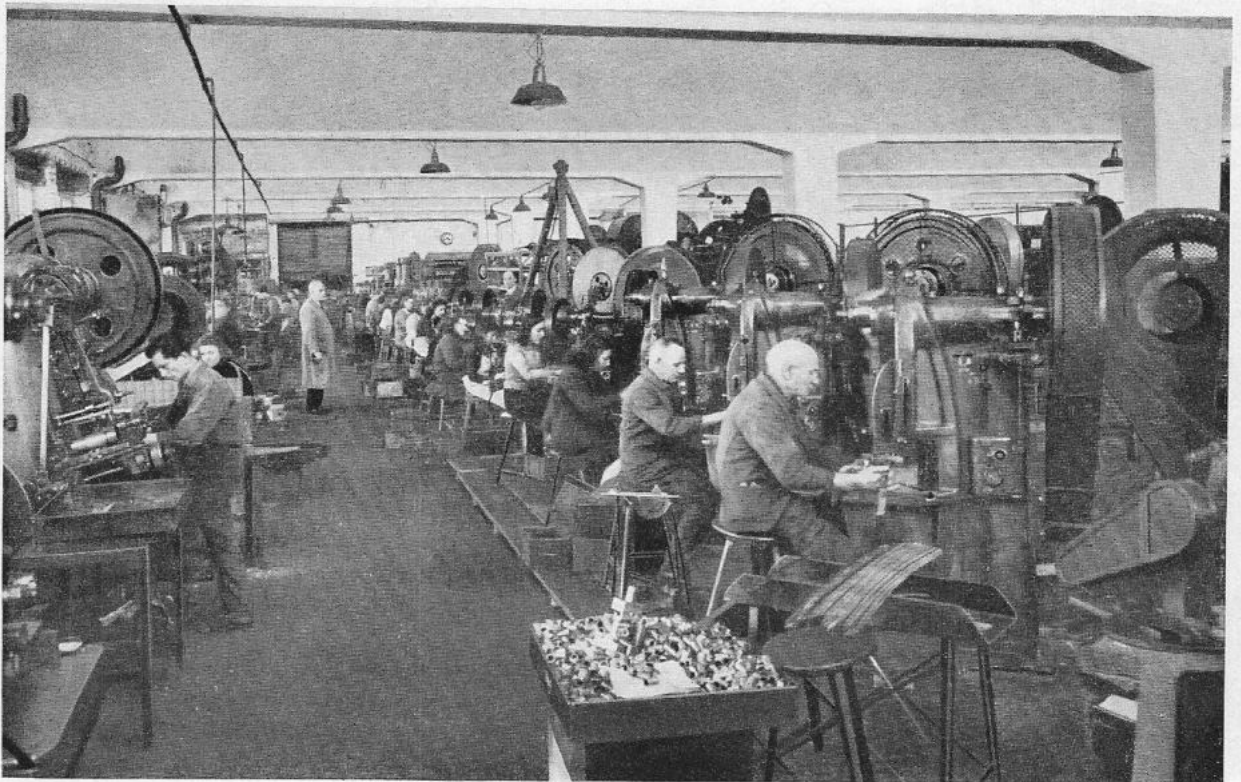
Stanzerei (Werk Frankfurt am Main)
