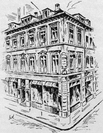
Haus Liebfrauenstraße 6, in dem sich 1899-1902 die ersten Geschäftsräume befanden
