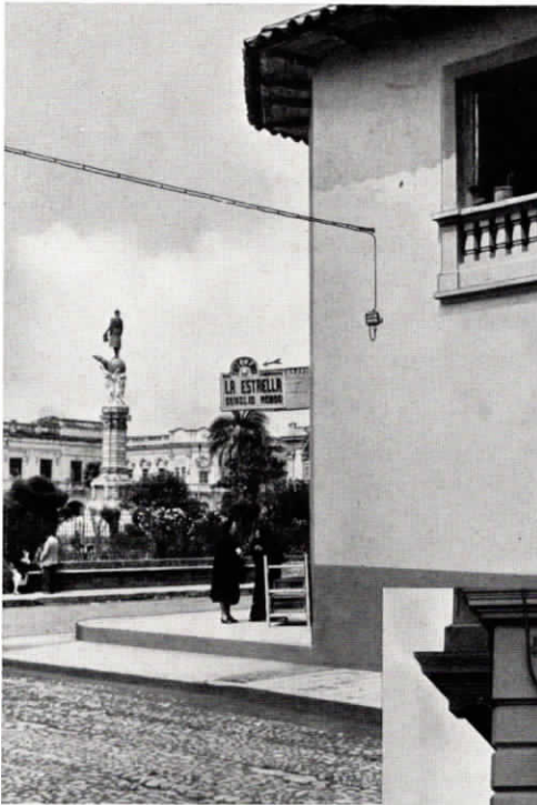
Abb. 8 Endverzweiger mit Luftkabelanschluß
