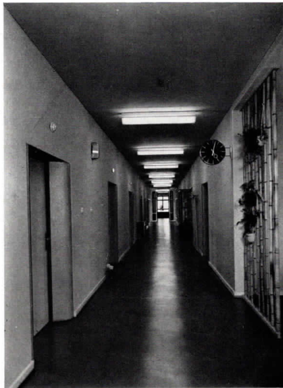
Abb. 6 Flur mit Lichtsignal-Zimmerlampen, Personensuch- und Gruppenlampen, sowie TuN-Innenuhr
