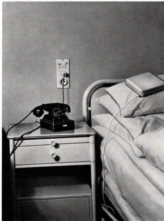
Abb. 4 Krankenbett mit Fernsprechapparat und Kissen- Lautsprecher
