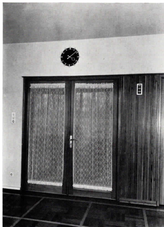
Abb. 7 Eingebaute TuN-Nebenuhr und Personensuchtablo
