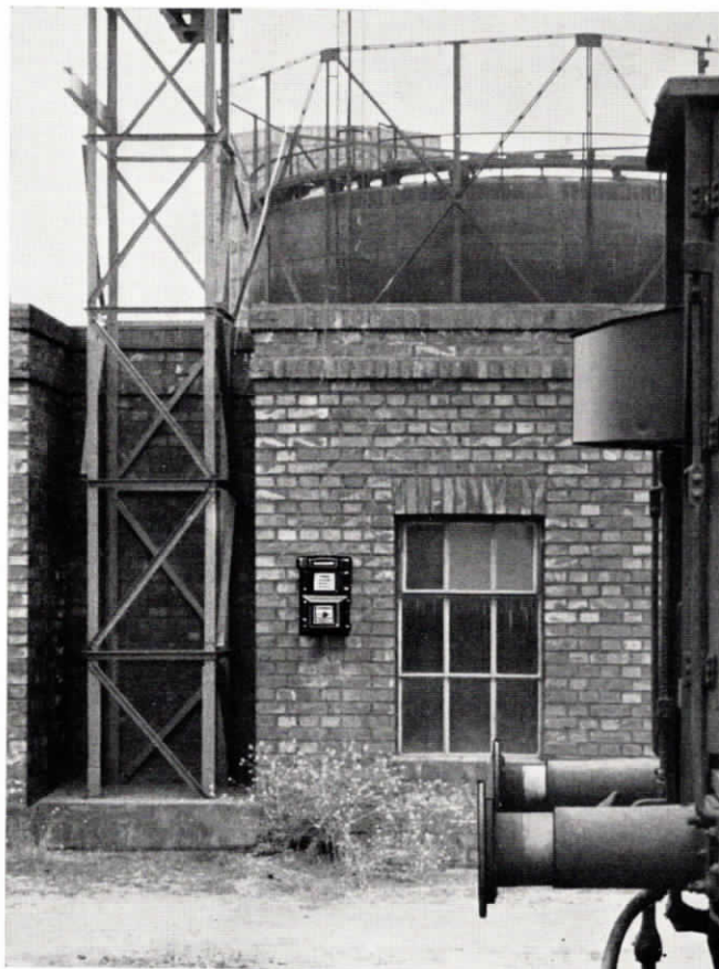
Abb. 5 Einer der über die Schachtanlagen verteilten öffentlichen kombinierten Feuer- und Unfallmelder
