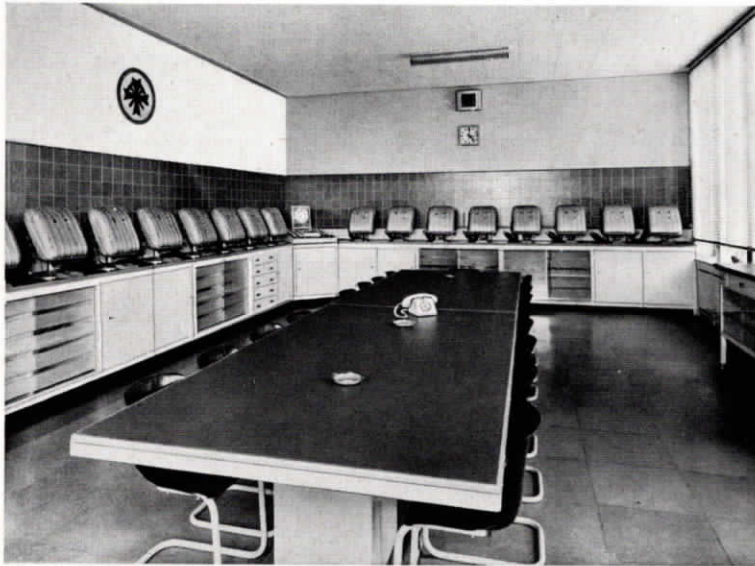
Abb. 8 Unterrichtsraum mit Fernsprecher, Lautsprecher und kombinierter Personensuch-Nebenuhr
