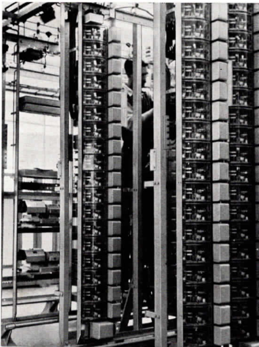
Abb. 3 Gestellreihe mit Ruf- und Signalmaschinen
