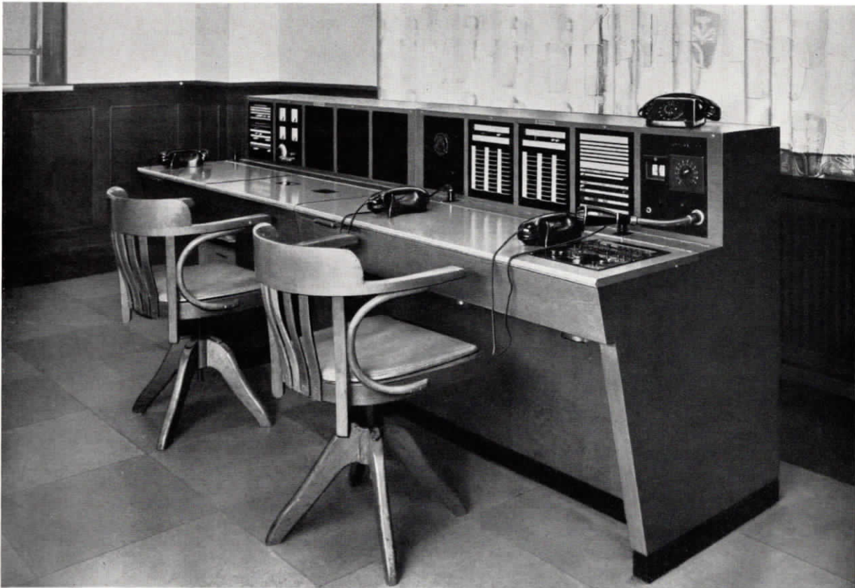
Abb. 2 Zweiplätziger Bedienungs- und Überwachungstisch für die Feuer- und Unfallmelde-Anlage, Fernsprech-Anlage, kombinierte Uhren- und Personensuch-Anlage, Rundspruch-Anlage sowie der Alarm-Anlage
