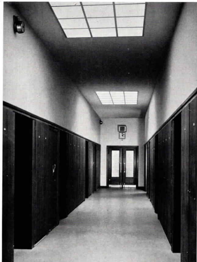
Abb. 9 Flur mit Starktonläutewerken, Lautsprecher und kombinierter Personensuch-Nebenuhr
