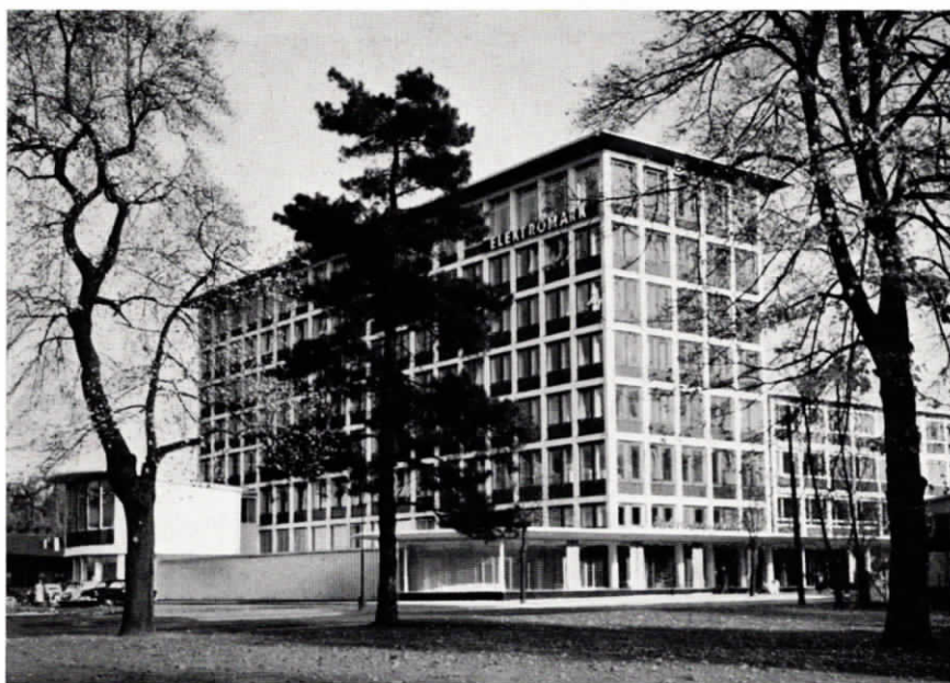
Abb. 8 Kommunales Elektrizitätswerk Mark A.G. in Hagen (Westfalen)
