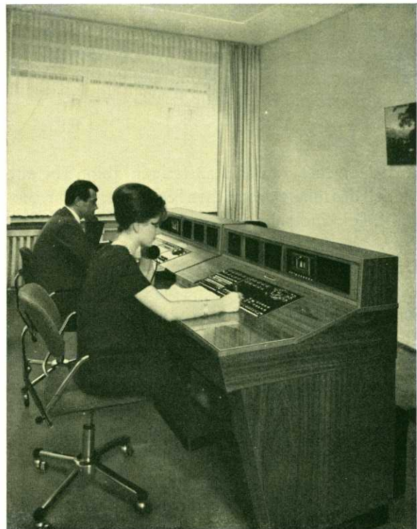
BILD 3 Bedienungstisch einer großen Wähl- Nebenstellenanlage der Baustufe III W
