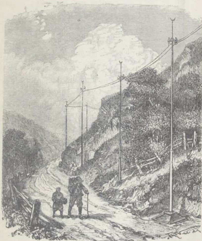
Fig. 47. — Poteaux Siemens Halske et Cie.
