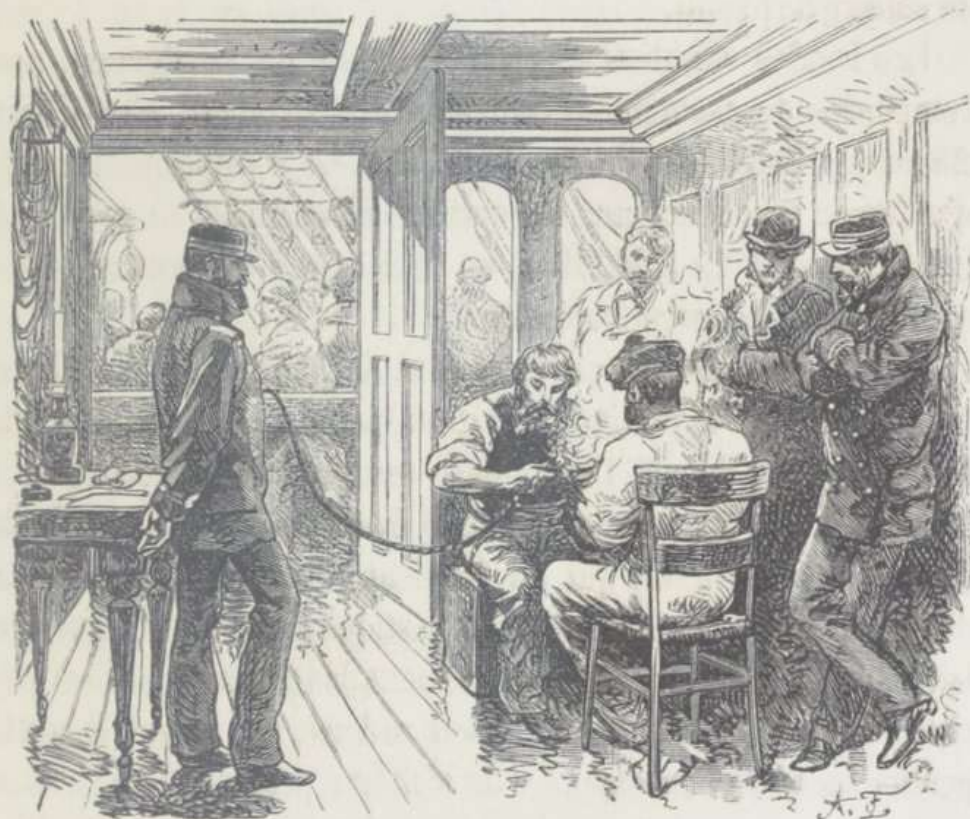
Fig. 93. — Opération de la soudure du câble.
