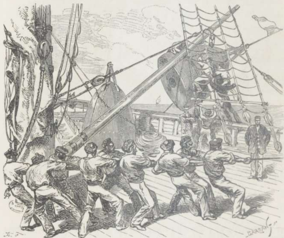
Fig. 124. — Descente de la bouée du câble.
