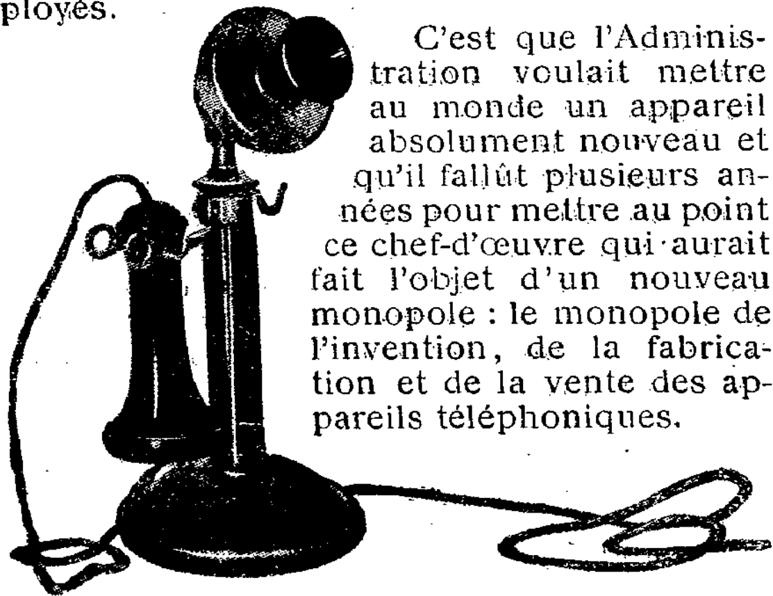
Type américain à batterie centrale intégrale.
