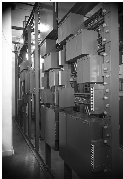
Vue intérieure avec capots fermés et ouverts. Enregistreurs et Taxeurs Interurbain.
