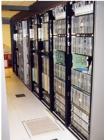
Photos des baies du système E10N1 de CIT Alcatel, à Fontainebleau
