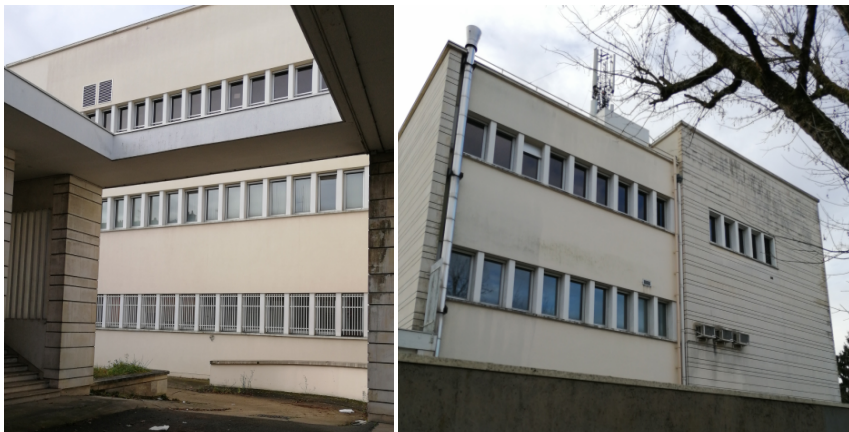
Vue actuelle de l'entrée rue de la paroisse, du premier et deuxième étage de la face nord.
