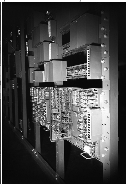
Vue intérieure avec capots fermés et ouverts. Enregistreurs et Taxeurs Interurbain.
