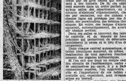
Vue d'une partie du réparateur
