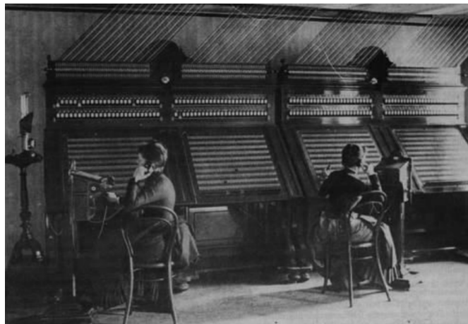
En 1898, la « Centrale » de l'entreprise, aujourd'hui appelée « Staats-Telephon LinzUrfahr » de 1893, fut déplacée de la place principale vers le bâtiment principal de la poste, Domgasse 1. Elle a été conçue pour 5x100 « positions d'abonnés ».
