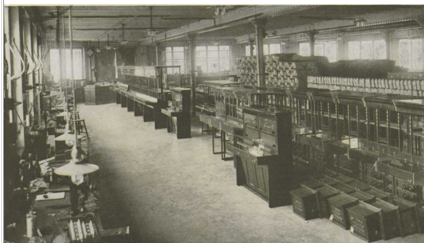
Salle de montage des commutateurs
