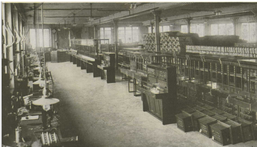
Salle de montage des commutateurs
