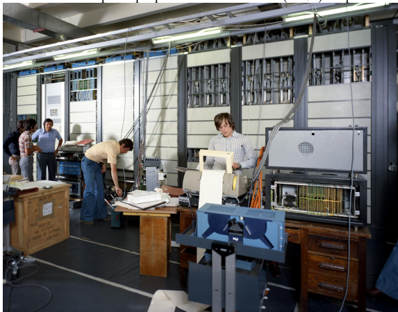
Salle du Réseau de Connexion du Commutateur prototype MÉTACONTA E11 Athis-Mons A1. Carte équipée de relais à tiges et contacts scellés (modèles HERKON) appartenant au Réseau de Connexion du Commutateur MÉTACONTA E11.
