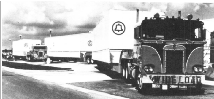
Figure 9-71. Transportable n°2A ESS. Les unités sont assemblées en usine avec des câbles connecteurs. Installé sur une fondation préfabriquée, le système fournit rapidement le service pour 3000 lignes.
