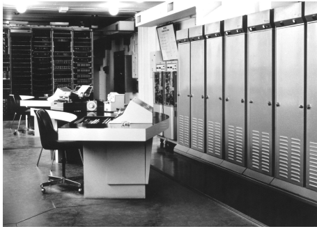
A Lannion, le Commutateur ARISTOTE est mis en service en exploitation réelle sur le réseau téléphonique public le 10 février 1966.
