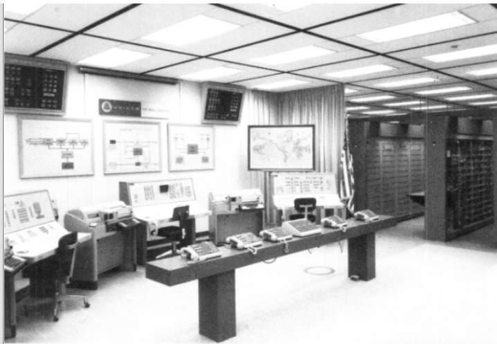
Figure 9-46. Une partie des consoles centrales de commutation de modèle de test UNICOM et des ensembles de contrôle de station numériques et analogiques.
