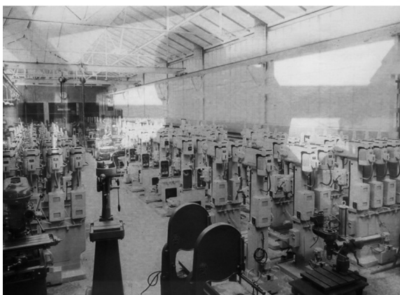
Société des Téléphones GRAMMONT, immeuble Régina à Malakoff. Atelier de fabrication 2
