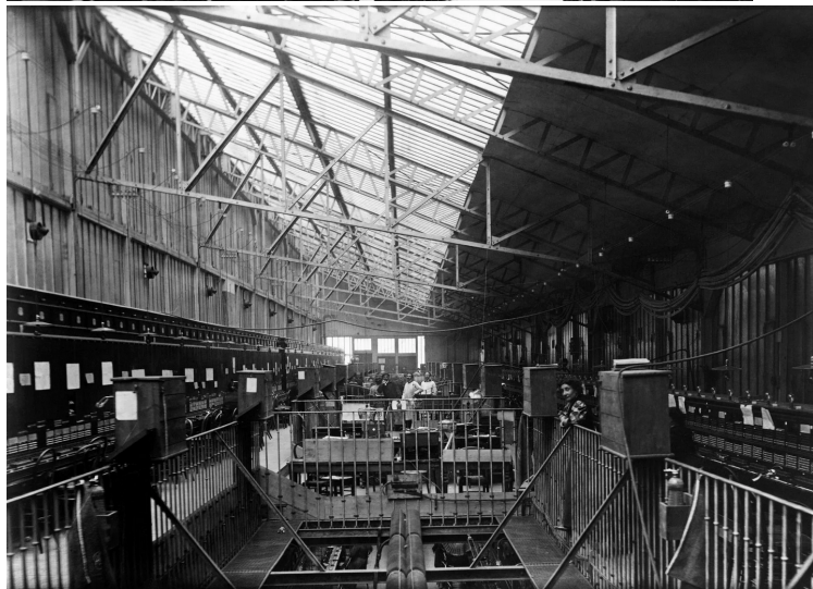
Chantier terminé, photo du Rez-de-chaussée et du premier étage.
