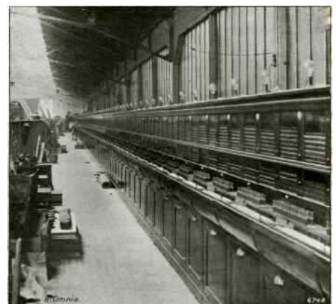
VUE D'ENSEMBLE DES GROUPES DE DÉPART PENDANT LE MONTAGE.
