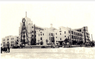
L'usine de Shibaura, construite pour fabriquer des centraux automatiques
