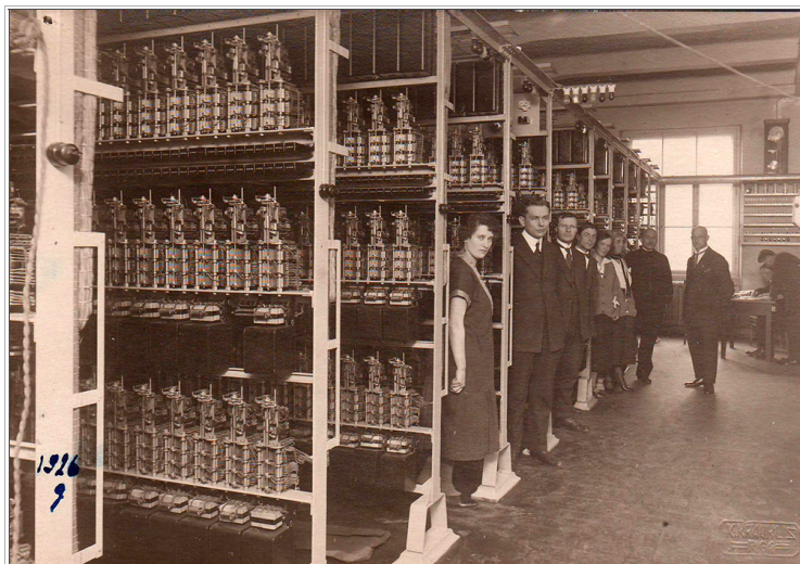
C'est un système Ericsson rotatif pas à pas.
