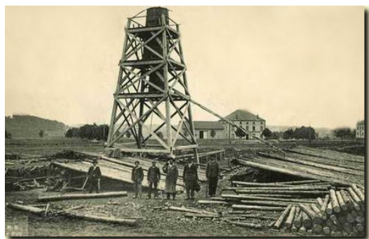
Tour d'imprégnation de poteaux en sapin de Usson en Forez.
