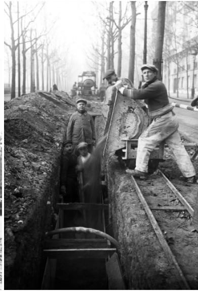
Pose des câbles en sous sol paris et autres grandes villes et dans une tranchée en banlieue et en province vers les petites et moyennes villes.
