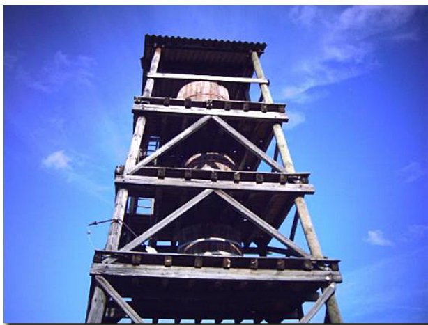
A Saint-Alyre-d'Arlanc, l'entreprise de fabrication de poteaux avait mis en place une station d'imprégnation au sulfate de cuivre. Les beaux cristaux bleus étaient livrés en sacs de jute de 50 à 100 Kg en provenance de l'Angleterre.
