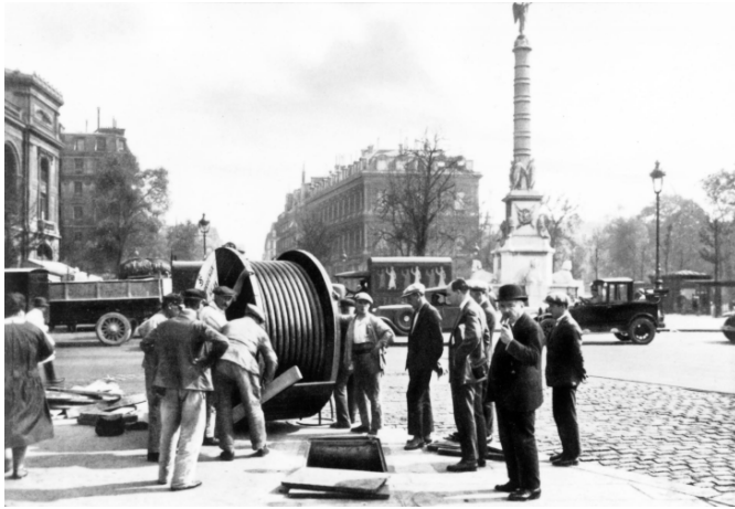
Pose des câbles en sous sol paris et autres grandes villes et dans une tranchée en banlieue et en province vers les petites et moyennes villes.
