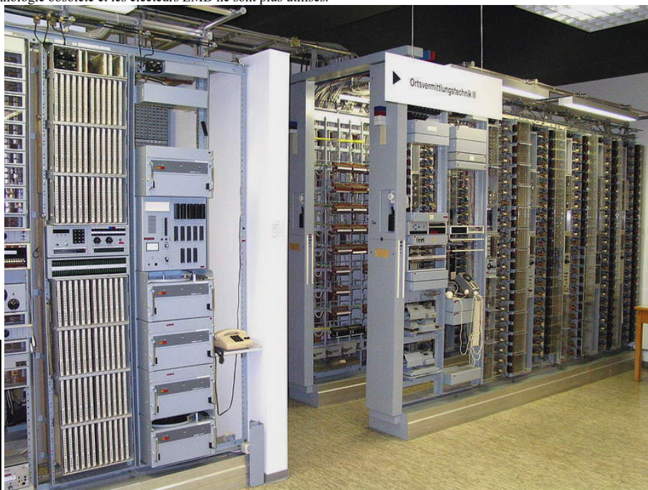
Sélecteurs EMD du dernier échange analogique allemand en 1997. Central 55v
