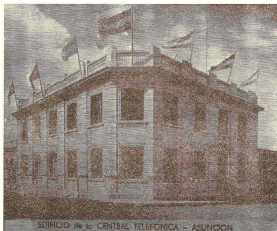
Edificio de la Central de Telecomunicaciones, en Alberdi y General Díaz
