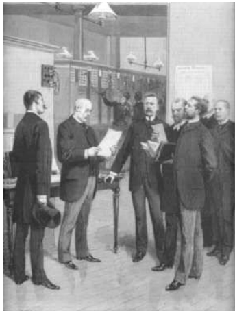
Chaque Commissaire de police lit l'arrêté du 30 août 1889 à haute voix, puis chaque responsable local de la Société Générale des Téléphones remet une protestation écrite, le tout en présence d'huissiers de justice. À la reprise par l'État, le Réseau de Paris compte 6.504 abonnés au téléphone.
