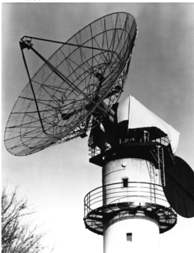
La tour de Nançay supportant l'antenne réceptrice pointant vers le satellite ECHO 1A .
