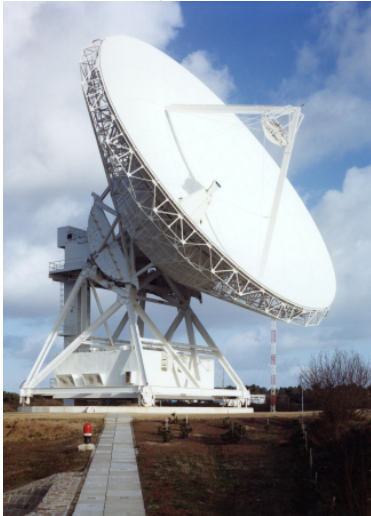
Antenne parabolique de conception française de 30 mètres de diamètre.
