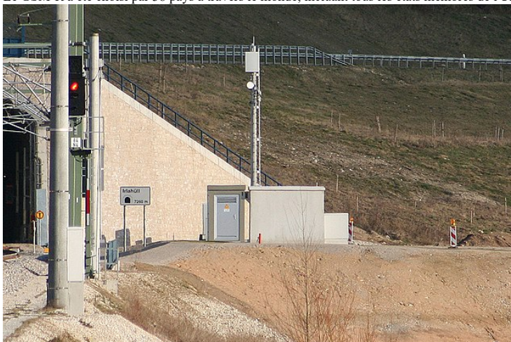
Mât d'émetteur GSM-R, ligne ferroviaire à grande vitesse de Nuremberg-Ingolstadt
