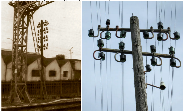
Poteaux PTT sur une ligne SNCF : la rangée supérieure comprend quatre isolateurs simples remplaçant deux « clés de sol », permettant la permutation des fils par rapport à la terre. Pour passer de l'isolateur supérieur d'une « clé de sol » à l'isolateur inférieur, le fil utilise à titre transitoire un isolateur simple intermédiaire qui le positionne à une hauteur proche du support transversal. L'angle de la déviation du fil est moins importante car répartie sur plusieurs poteaux successifs.
