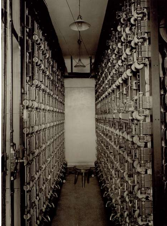
1923 Landskrona. la Station Rotary semi-automatique avec moteur à entraînement mécanique....
