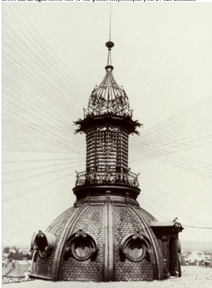
Sur le toit d'un ancien central téléphonique
