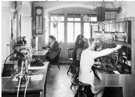
Central téléphonique rural d'Einsiedeln vers 1948. Quelques mois plus tard, ce central était automatisé.
