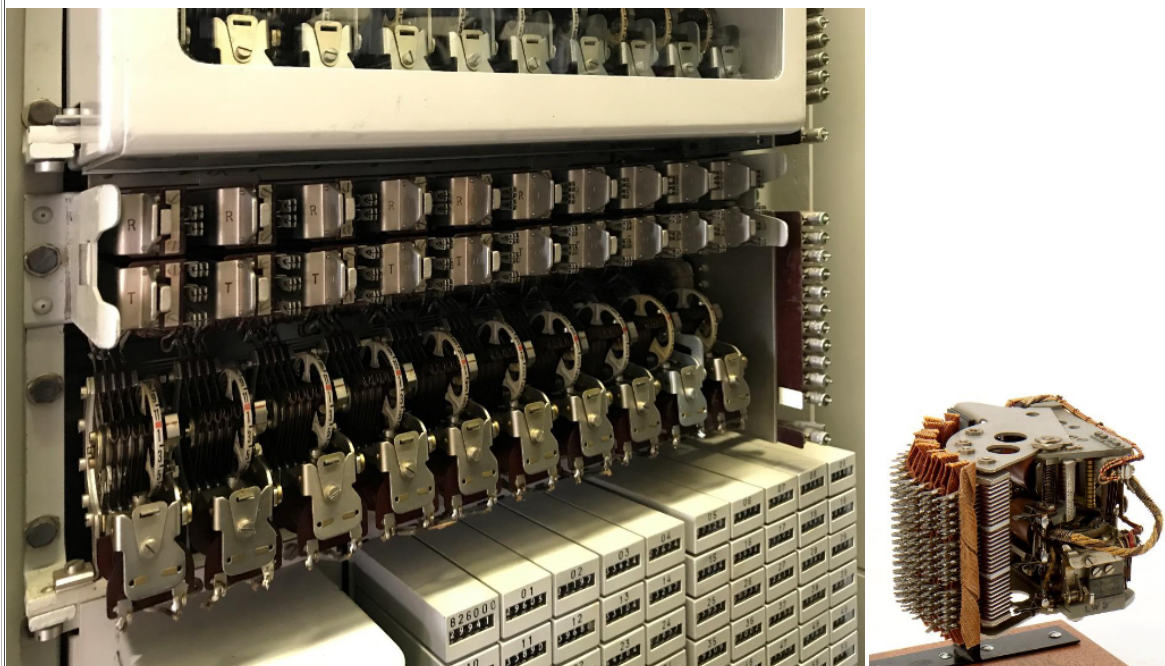
Disposition des sélecteurs, relais et compteurs de taxation. Détail d'un sélecteur rotatif.
