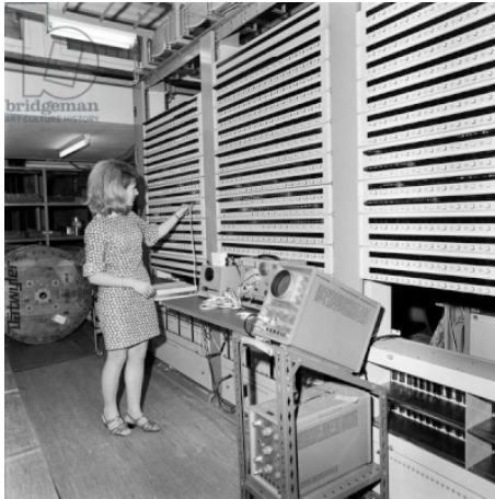
Un employé de l'administration téléphonique contrôle le nouveau système Pentaconta au bureau central de Fuessli, le bureau central de la ville de Zurich, qui permet l'auto-numérotation dans d'autres pays européens (enregistré le 30 avril 1968).
