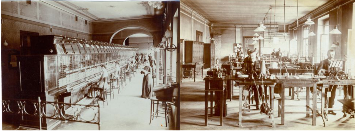
Central téléphonique du système à batterie local, en 1910. et Centrale télégraphique de Prague Appareil Hughes dans le hall, avant 1914.
