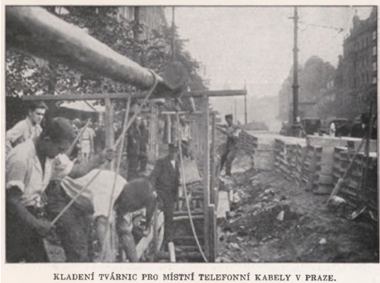
POSE DE BLOCS POUR CÂBLES TÉLÉPHONIQUES LOCAUX À PRAGUE. — APERÇU DES COÛTS DE L'EXTENSION PROGRESSIVE DU RÉSEAU DE PRAGUE
