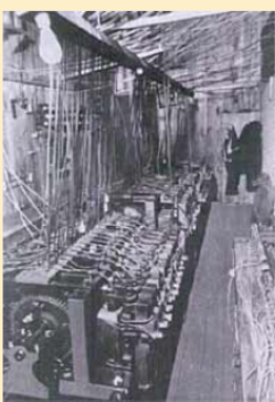
© McClure's Magazine – juillet 1906 - Les dynamos du Telharmonium (2e version)
