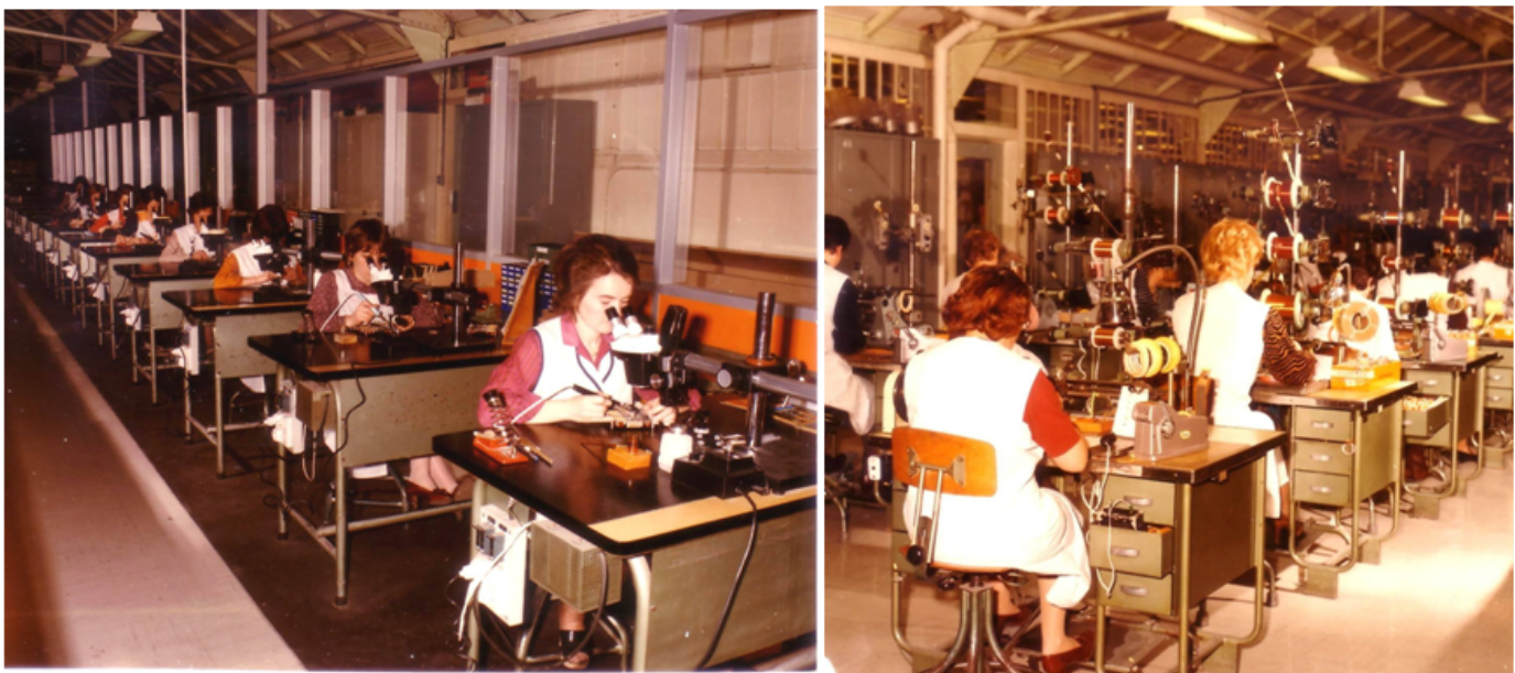
■ L'atelier de bobinage et de montage sous loupe binoculaire (1984) (Collection Guy Pireyre)
