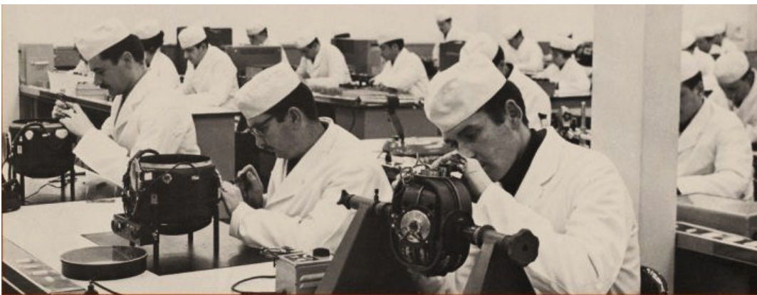
■ L’atelier de fabrication des centrales de cap et de verticales
