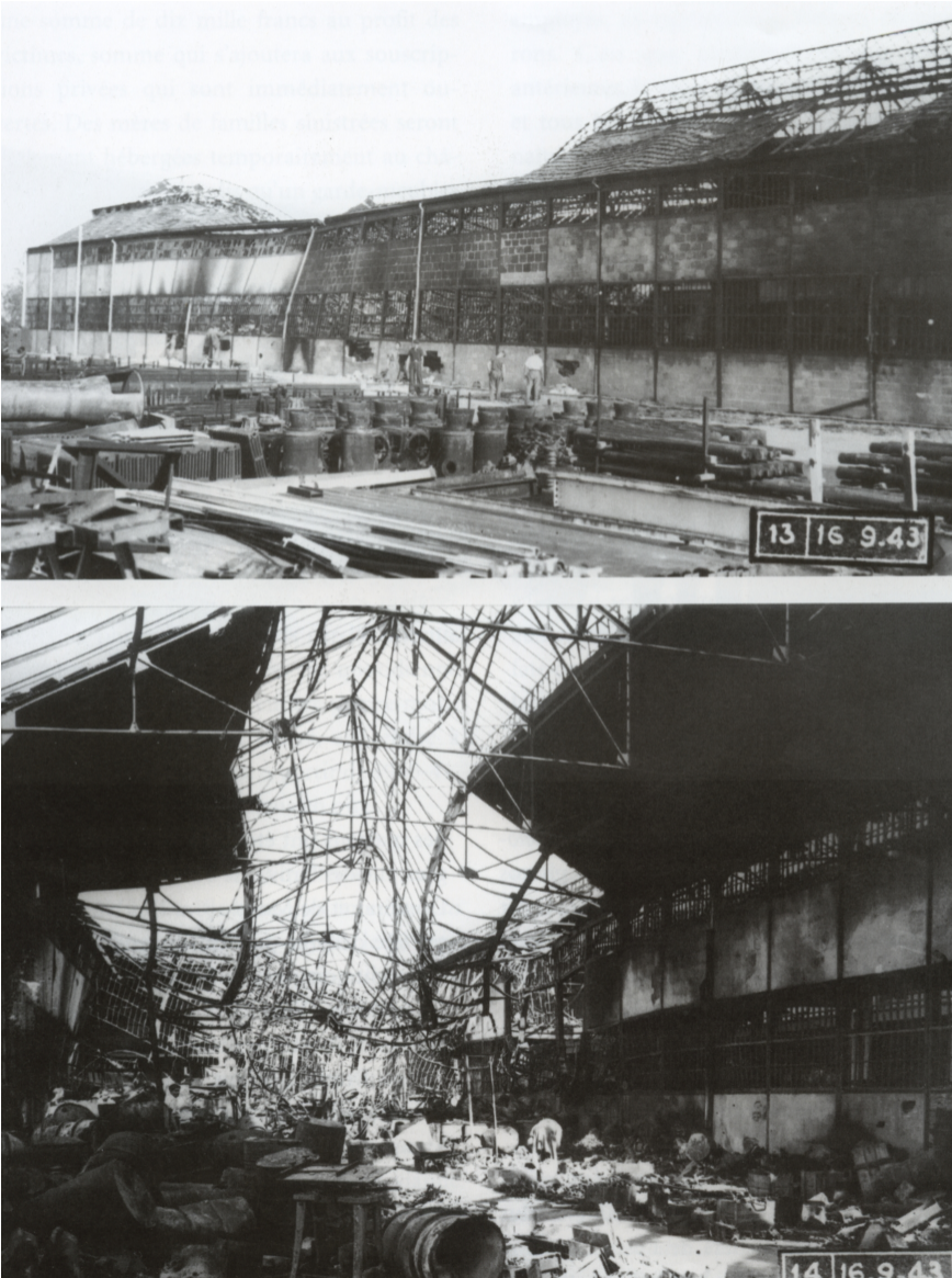
■ Vues extérieure et intérieure du hall 6 de l’usine dévasté après le bombardement
